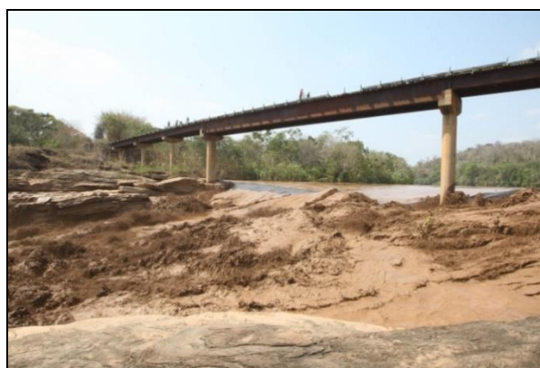
Lama atinge rio Doce e compromete o abastecimento de água
